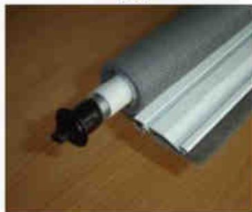
in die neue Welle links Feder einführen und Gleitring mit Nase aufschieben
