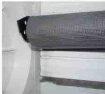
Welle nach rechts drücken und aus dem linken Lager entnehmen
