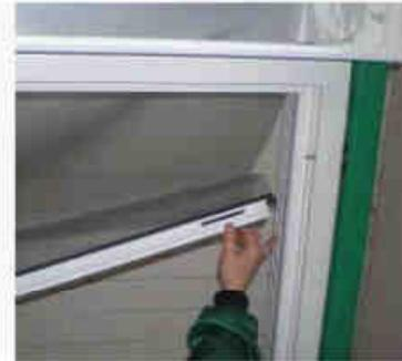
Zugschiene diagonal aus Führung herausnehmen
