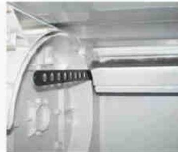
Welle leicht nach rechts eindrücken und das Lager links einrasten lassen
