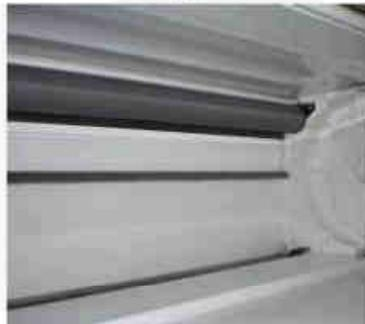
Zugschiene wieder einführen und in den Kasten einschieben
