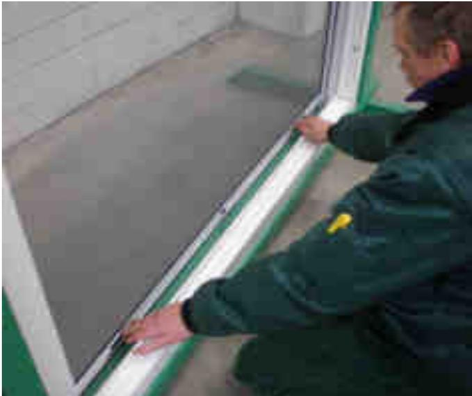
Zum Schließen des Gewebes, drücken Sie die Zugschiene (nicht an den Griffen) nach außen unter die Riegel.
