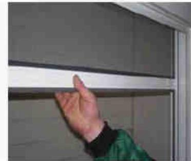
Zugschiene in Rolladenlaufschiene einführen
